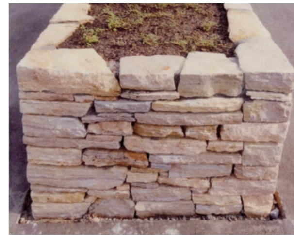
小端積(深目地) 石厚(乱尺)20~100mm
