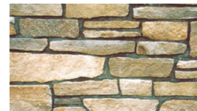
小端積(深目地) 石厚(乱尺)20~100mm
