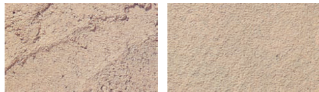
ラフ仕上げ くばりローラー仕上げ
