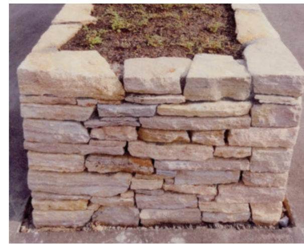
小端積(深目地) 石厚(乱尺)20~100mm
